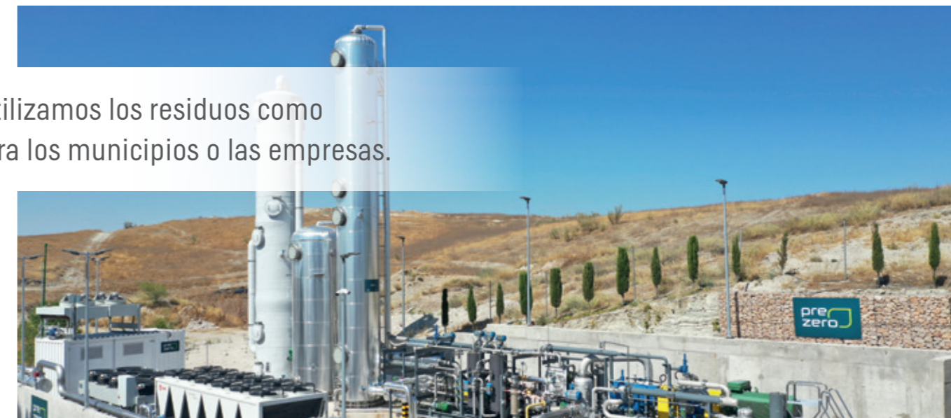
La planta de biogás de Valdemin-gómez procesa los residuos orgánicos de los 3,2 millones de madrileños para convertirlos en biometano.
